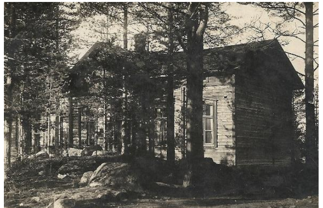
Kuva: Vuonna 1906 toimintansa aloittanut Kääntymän kansakoulu ilman vuorilaudoitusta Latukan mäeltä päin kuvattuna.
